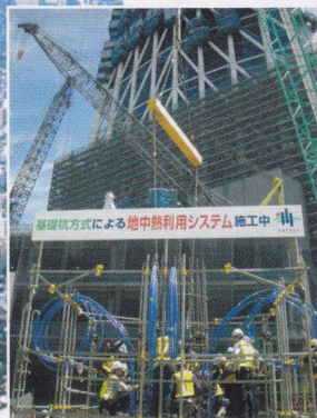
基礎杭方式 施工：大成建設
